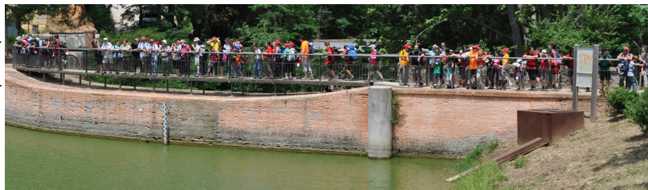
Pontà de Vallvidrera. (foto: Felip Serrano)
