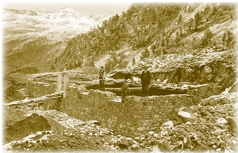
Construcció refugi de la Renclusa (1912-1916)
